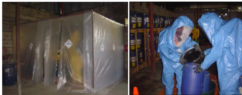
Figura 3. Zona caliente y manipulación de tambores con el uso de trajes de protección
